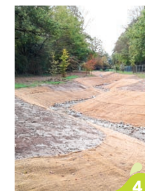
Le Noiron à Aizenay parc des Engoulevents Travaux réalisés par la commune d'Aizenay
