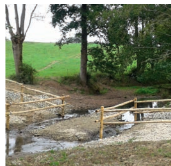
Aménagement de passages à gué 15 passages à gué ont été aménagés afin de permettre un franchissement respectueux du cours d'eau. Le reste à charge (20%) est financé par l'exploitant ou le propriétaire.
