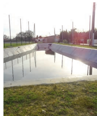
Bassin de récupération des eaux pluviales pour l'arrosage du terrain de sports
