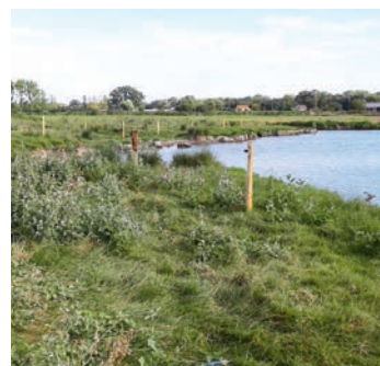
Pose de clôtures (7,4 km) et aménagements d'abreuvoirs (84) 28 exploitations volontaires ou propriétaires se sont équipés de dispositifs d'abreuvement et/ou de clôtures permettant de protéger les berges et de sécuriser l'approvisionnement en eau des troupeaux. Le reste à charge (20%) est financé par l'exploitant ou le propriétaire.
