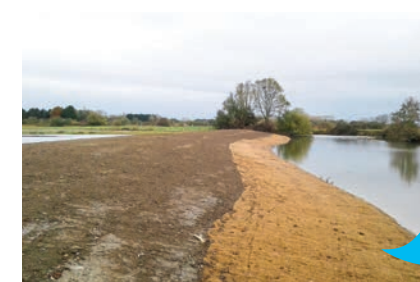
Le Ligneron à Notre-Dame-de-Riez Restauration de berges par adoucissement et plantation d'hélophytes
