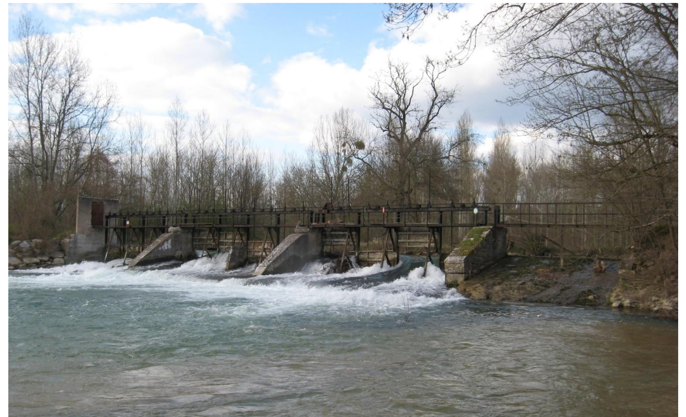
FIGURE 30: BARRAGE DU MOULIN DE CHAMPDOTRE RESTAURER ET EQUIPE EN 2015 POUR LA PRODUCTION D'HYDRAUELECTRICITE
