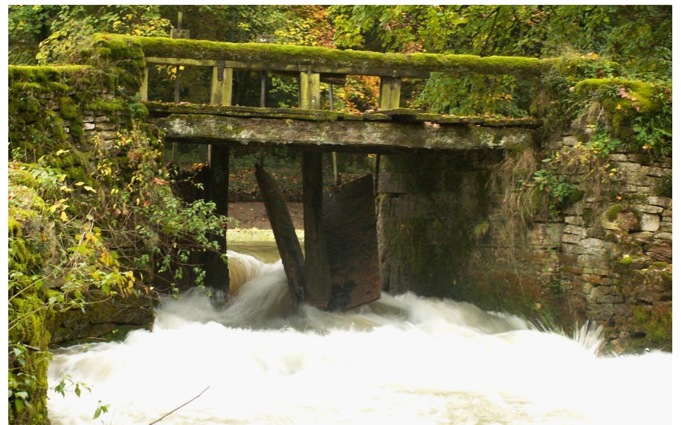
FIGURE 32: VANNES HORS D'USAGE
