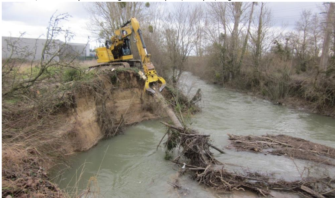
FIGURE 27: TRAVAUX DE RETRAIT D'EMBACLES AU DROIT D'UNE IMPORTANTE EROSION DE BERGE (LA TILLE A GENLIS - 2014)
