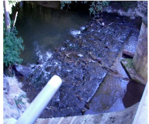
Cependant, les seuils fixes qui ont pour principales vocations de diminuer la vitesse d'écoulement et d'augmenter le niveau d'eau à l'amont de l'ouvrage peuvent être à l'origine d'inondations de la zone située à proximité de la retenue d'eau et ce, notamment, dans le cas d'une rivière à pente faible. A fin d'éviter cela les ouvrages mobiles ont donc été créés.
