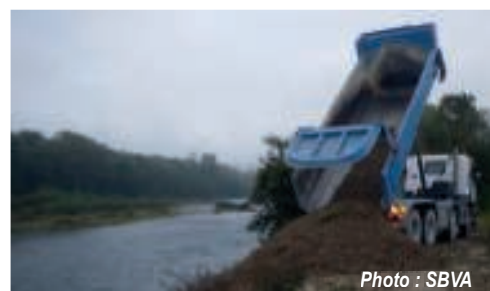
Apport de galets de l'Albarine sur un secteur de la rivière d'Ain en déficit. Ce type d'opération permet à la fois de limiter le risque d'inondation de riverains de l'Albarine et participe à limiter l'enfoncement de la rivière d'Ain.
