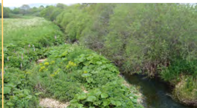
Le lit de l'Albarine obstrué à Brénod empêchait le bon écoulement de l'eau
