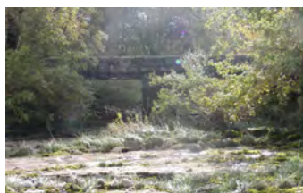
Sur le plateau, l'eau de l'Albarine s'est infiltrée dans le massif à travers les fissures.
