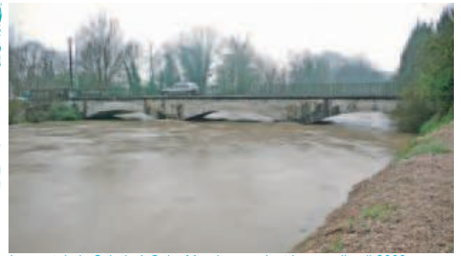
Le pont de la Scierie à Saint Maurice pendant la crue d'avril 2008
