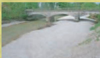
Les galets déposés au niveau du pont de la Scierie
