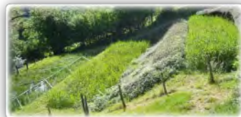
Station d'épuration de Cleyzieu
