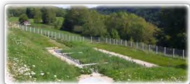
Station d'épuration de Lacoux
