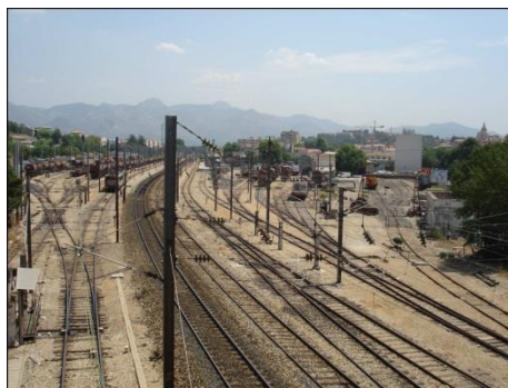
Figure 3 : Voie ferrée TER au Nord d’Aubagne
