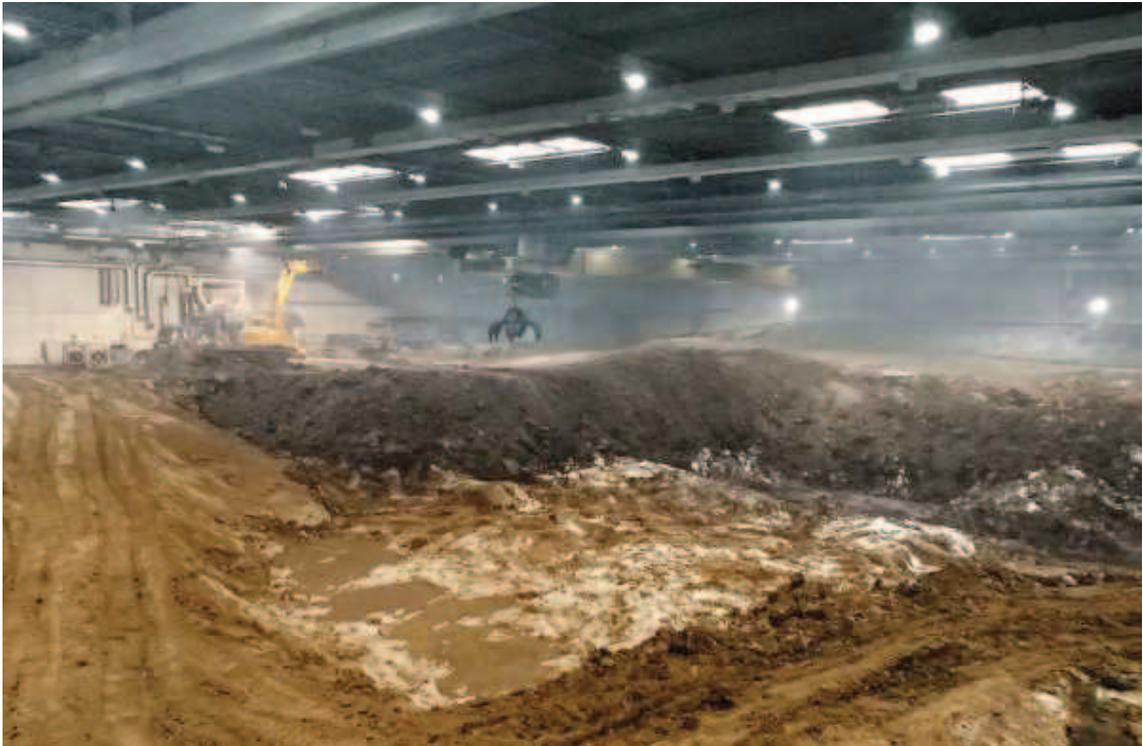
**Figure n° 15: Dans la halle d'excavation, le fond argileux de la décharge réapparaît sous les déchets industriels (état en août 2012) (Droits : bci Betriebs-AG)**
