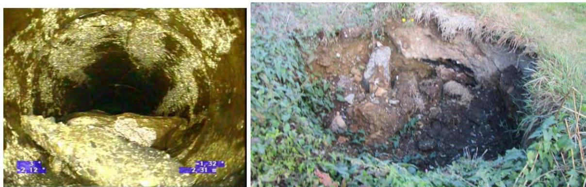
Figure 9 : Effondrements observés niveau de la zone de Coat conq à Concarneau (photo 1 : effondrement de la canalisation, photo 2 : effondrement observé au niveau de la canalisation d'évacuation des eaux pluviales).
