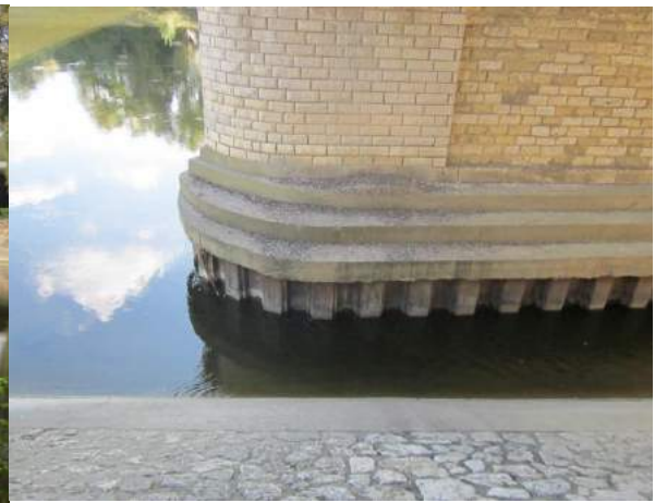
Massifs de fondation
