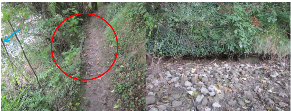
Fig. 63. Chemin le long de la berge et érosion (sous-cavage) au niveau de la retenue normale
