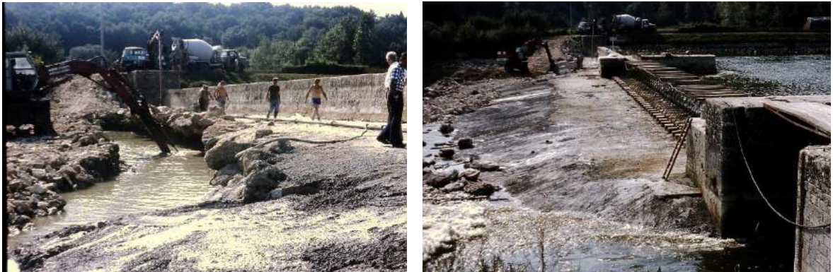
Travaux de confortement du barrage de Larçay (1982)
