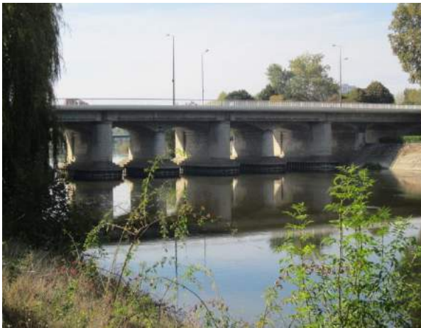
Pont sur le bras rive gauche
