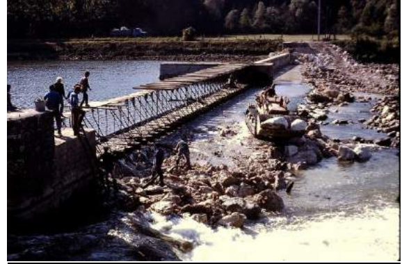
Travaux de confortement du barrage de Larçay (1978)
