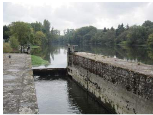
Ecluse en rive droite
