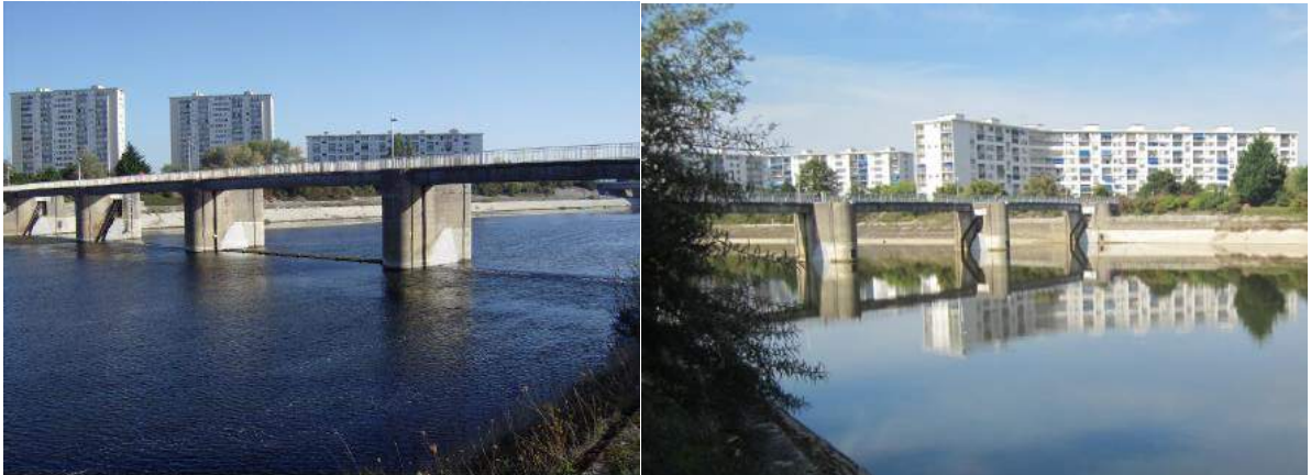
Clapets rive droite
