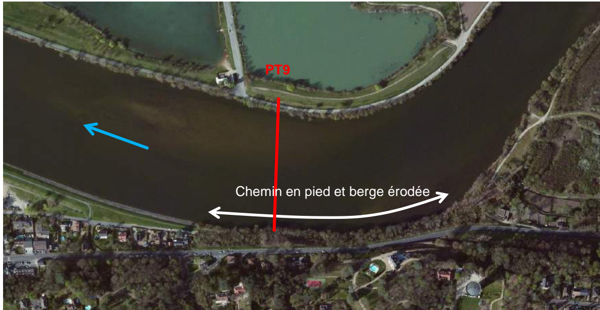
Fig. 62. Situation du virage de l'Ecorcheveau et du tronçon de berge exposé à l'érosion
