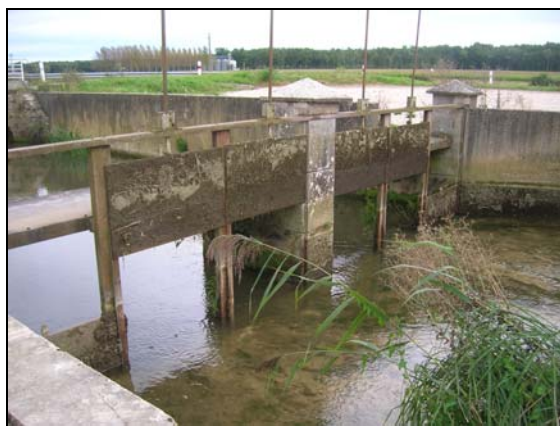
Ouverture des vannes du lavoir de Villebichot - Photo SBV
