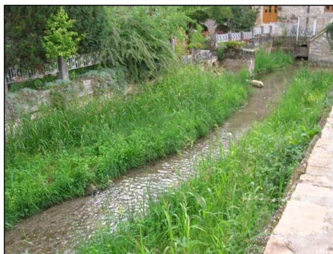
Situation après travaux - SBV
