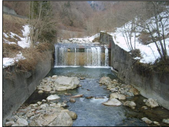
Figure : Barrages à l'amont de Moulin Ravier
