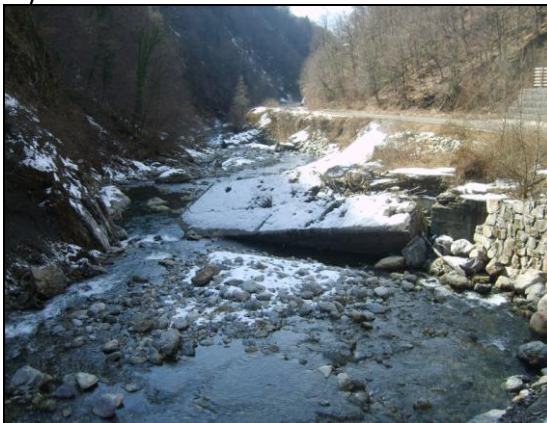
Épi basculé à la suite d'un affouillement local
