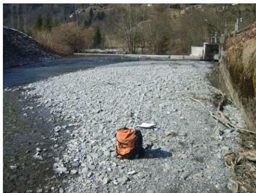
Barrage de Queige sur le Doron
