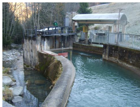
Barrage EDF d'Arêches sur l'Argentine
