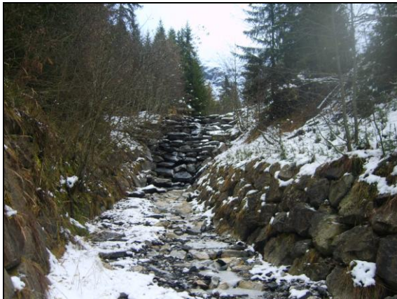
Incision du Glapet ayant nécessité la construction d'un seuil de 5m de haut
