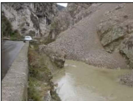
Chute de blocs de la carrière Vicat formant un barrage à l'écoulement
