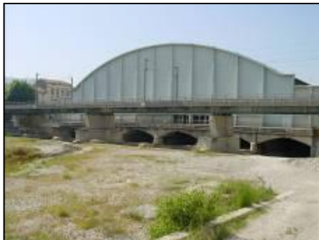
Entrée de la couverture du Paillon dans Nice
