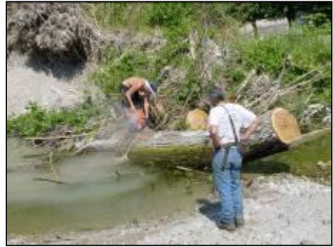
Travaux d'entretien de la ripisylve
