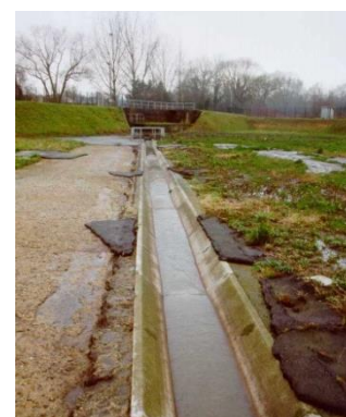
Le ru d'Arra dans le bassin de Groslay/Montmagny
