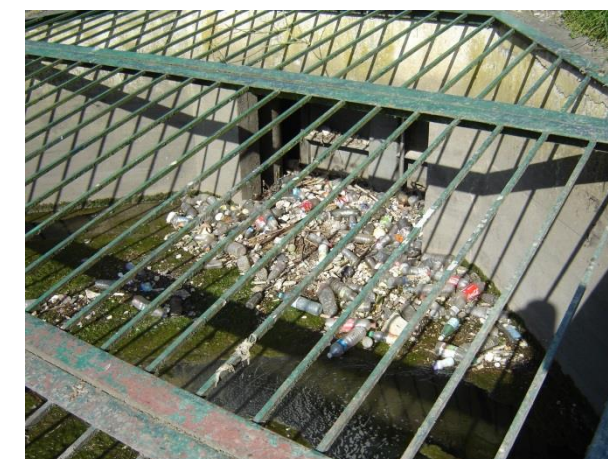
Ouvrage de décantation © SIAH, 2010
