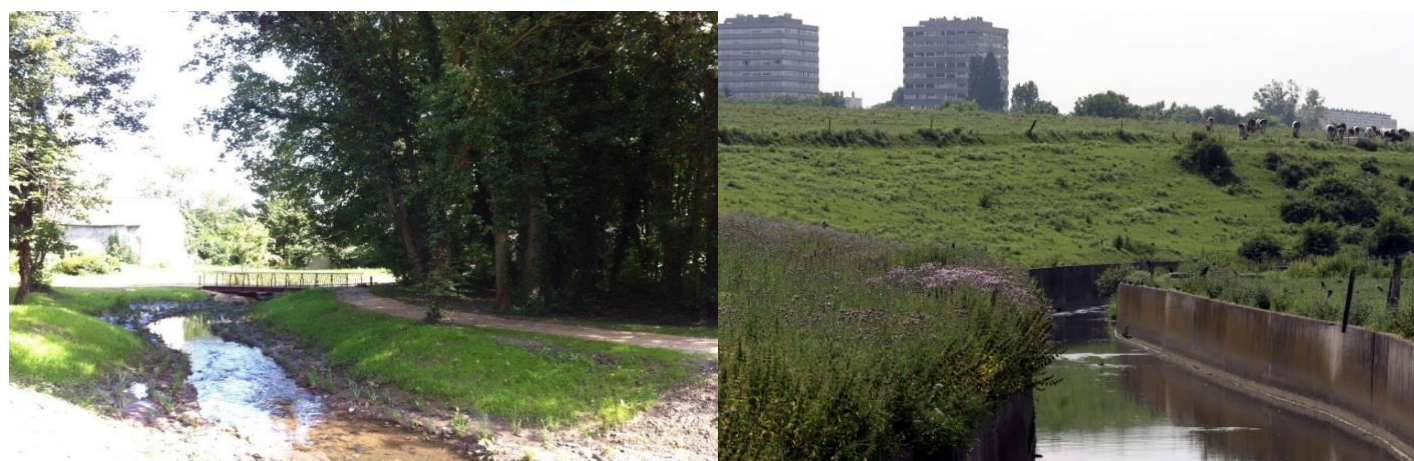
Réouverture, reméandrage et renaturation du Petit Rosne à Sarcelles © SIAH, 2014 Vallon du Petit Rosne © Biodiversita, 2013
