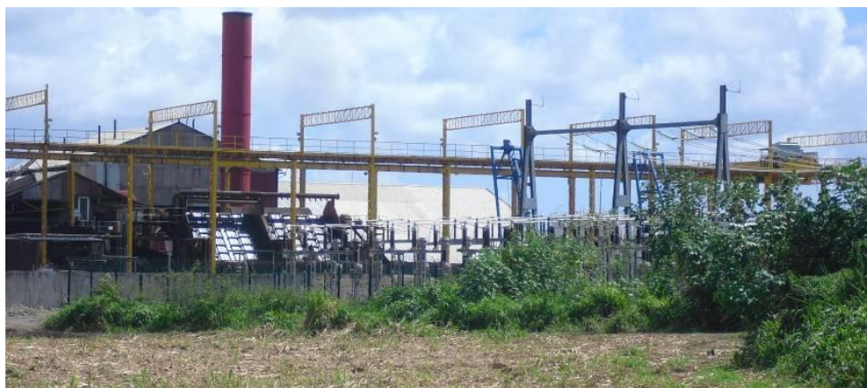
Figure 3 : La sucrerie du Galion et la centrale de production d'électricité du Galion
