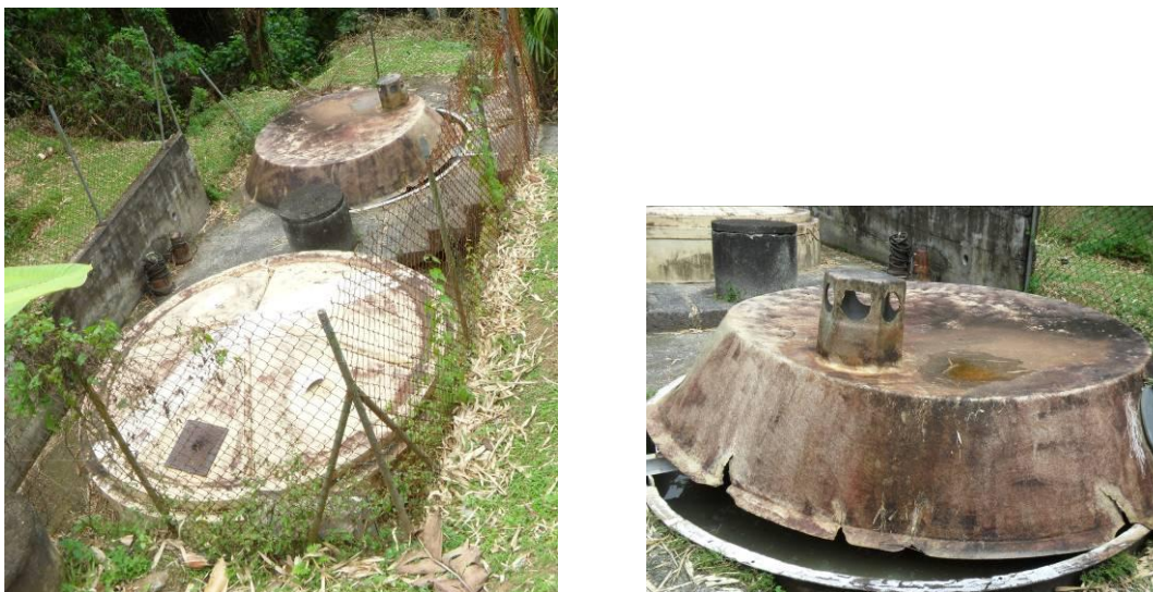
Figure 4 : La STEP Bon Air de Sainte-Marie est dans un état de dégradation avancé
