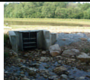
Exutoire du fossé
