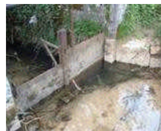
Entrée du canal Guichard
