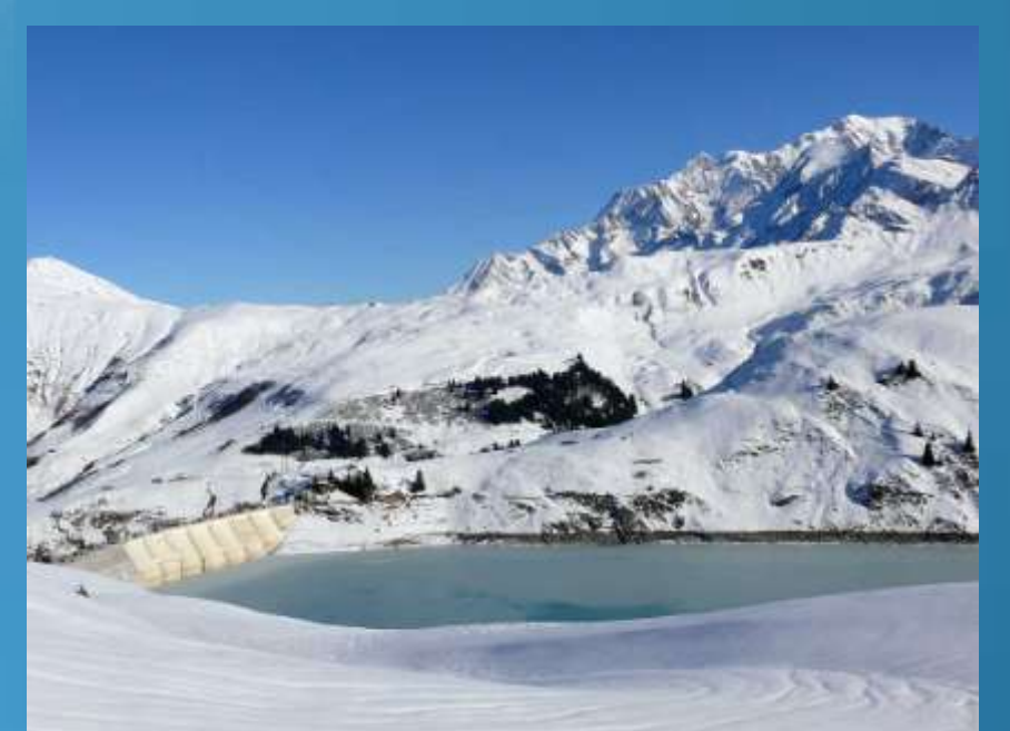
Le barrage de la Girotte
