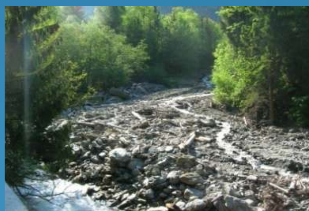
Déséquilibre du transport de matériaux causant localement des dégâts, risques de débordements ou à l'inverse déchaussements d'ouvrages (ponts, digues, ...)
