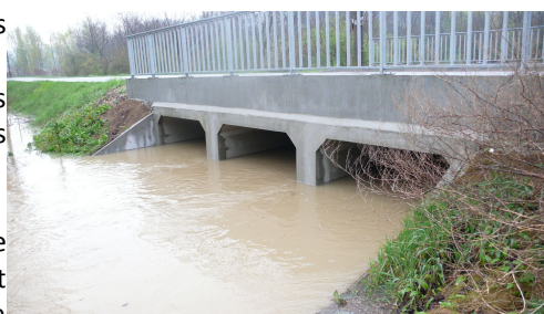
Figure 19: Mise en charge du dalot de Bettant (créé en 2006) lors de la crue d'avril 2008
