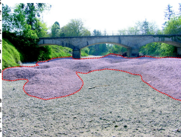
Figure 12: Accumulation de charge solide (d'un hiver) en aval du pont de la VC6 à Saint-Maurice de Rémens dans l'Albarine asséchée
