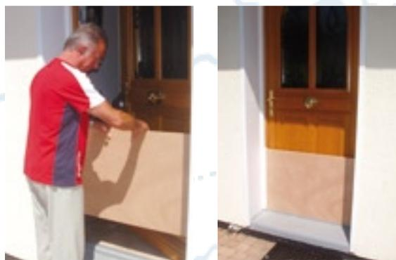
\*Planche glissée dans l'encadrement d'une ouverture afin d'empêcher l'eau de s'y engouffrer
