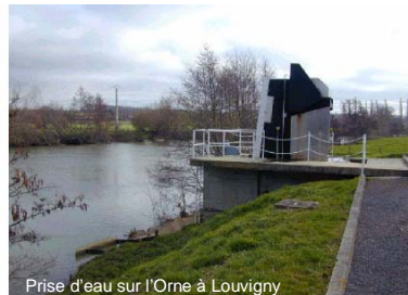
Prise d'eau sur l'Orne à Louvigny
