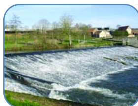
Barrage des Claies de Vire
