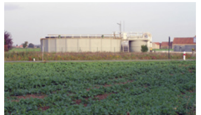
Station d'épuration de Vienne-en-Val
