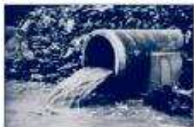
Rejets d'eaux usées
