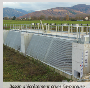
Bassin d'écrêtement crues Savoureuse
