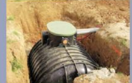
Cuve à enterrer en polyéthylène alimentaire recyclable
