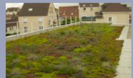
Toiture terrasse végétalisée (AESN)
