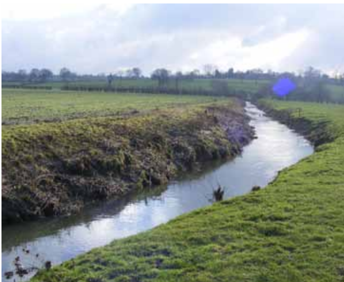
Avant travaux (Source : SIAECEA)
