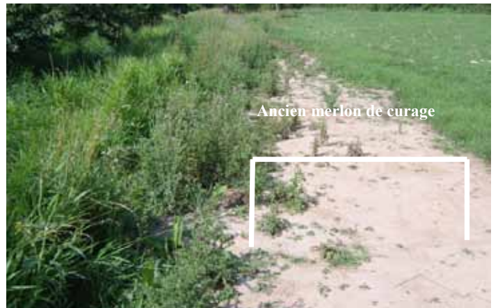
Arasement de l'ancien merlon de curage
