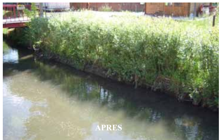
Berge de la Clarence avant et après travaux (Crédit photographique : Artois Comm)
