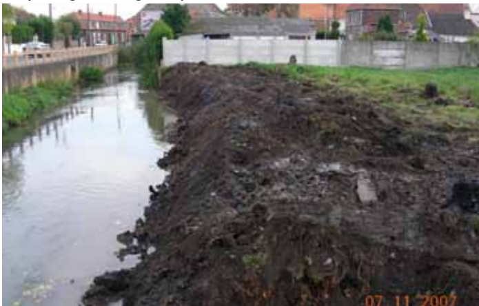
Retalutage des berges (Crédit photographique : Artois Comm)
