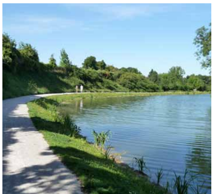
Avant, pendant et après travaux (berges végétalisées)
