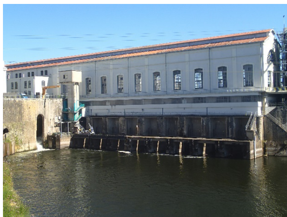
Barrage hydroélectrique de Tuilières partie aval
