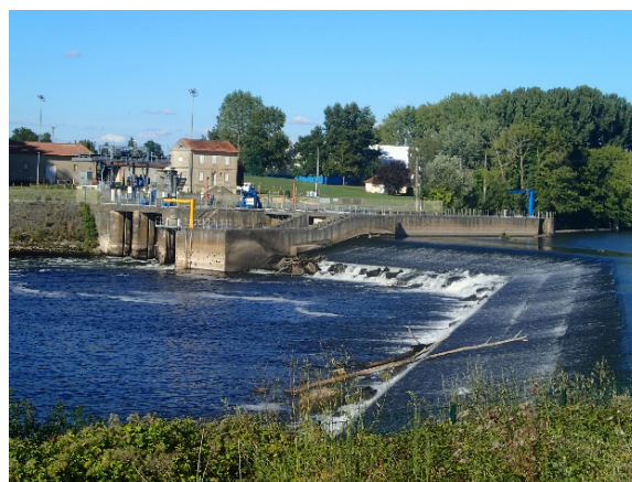
Barrage hydroélectrique et seuil associé de Bergerac
