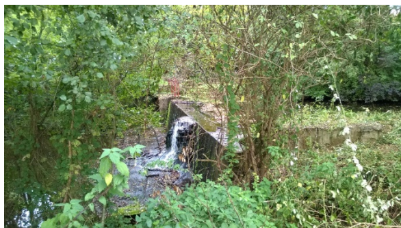
Seuil de Coutou, classé en ZAP, rivière Le Barailler. Ouvrage détruit en 2016
