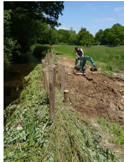
Figure 3 - Réfection d'une berge sur la Penfeld
