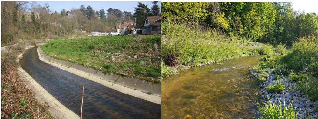
Figure 15 : Le changement spectaculaire de l'Yzeron à Oullins avant (à gauche) et un an après travaux (à droite)
