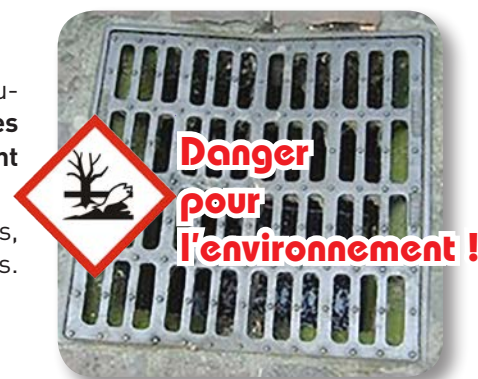
Plaque pour eaux pluviales et non d'égout
