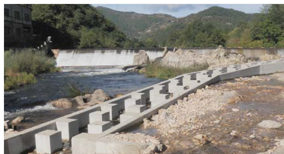
Passe à ralentisseurs, Eyrieux au Moulinon (St-Sauveur-de-Montagut)
