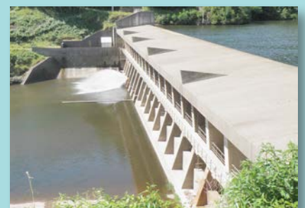
Vanne à jet creux au barrage des Collanges fonctionnant en été
