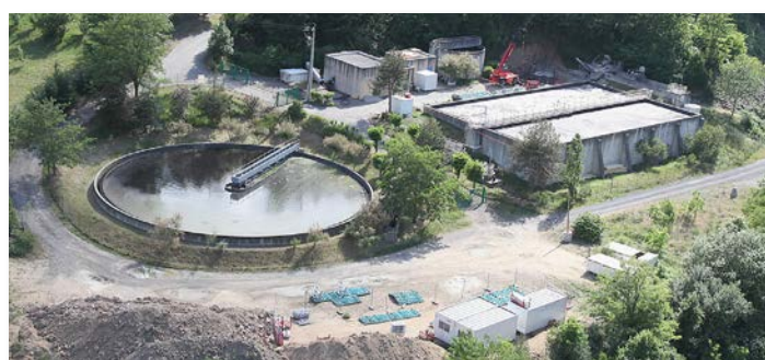
Travaux d'amélioration de la STEP
