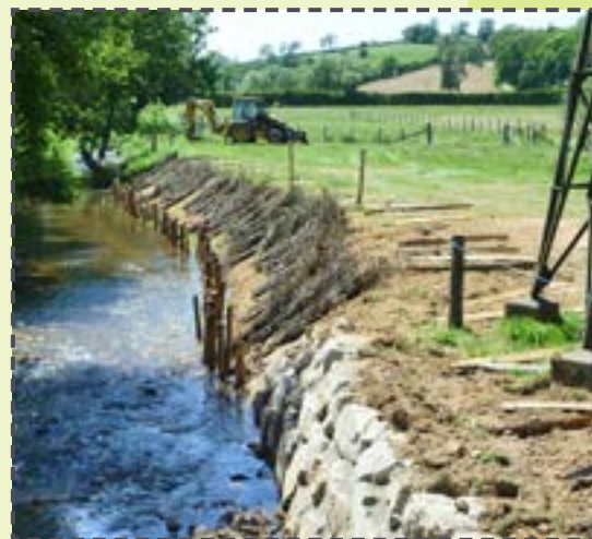
Travaux sur une rivière
