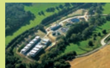
Station intercommunale d'Amplepuis Thizy © Gérard Bonin
