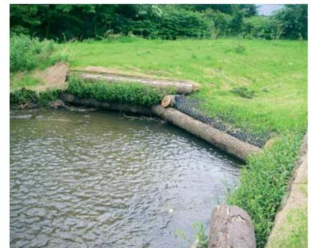
Caisson végétalisé. Cette technique a été utilisée sur les berges de l'Onzon, en aval du pont de la rue du Puits Pointu et en amont de la RD 1498, ainsi que sur un méandre de l'Onzon vers le stade de La Talaudière. Ces secteurs présentent des berges raides soumises à de fortes contraintes hydrauliques.
