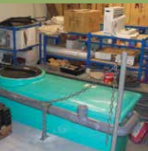
bac à graisse d'un restaurant
