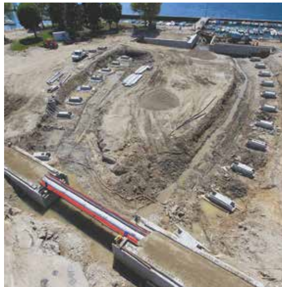
La construction du nouveau port à barques et l'une des passerelles
