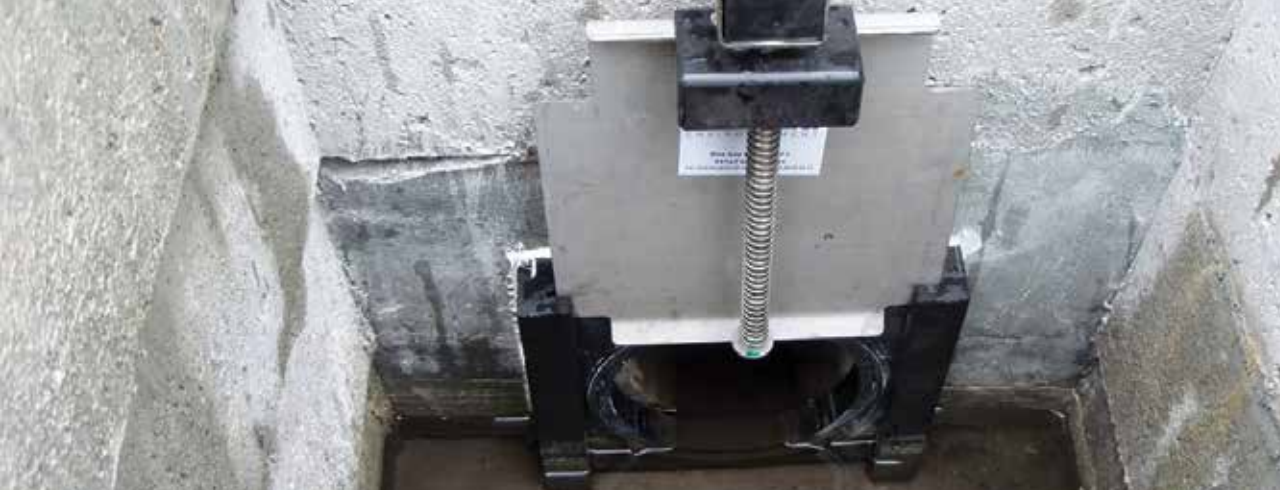
Vanne d'isolement du site pour protection contre les pollutions accidentelles
