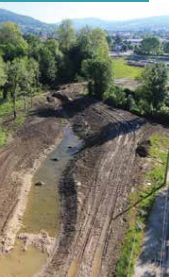
Le nouveau lit du Tillet sur le tronçon T2 avant végétalisation
