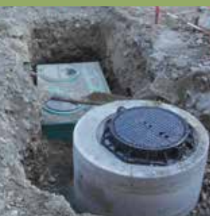
Séparateur hydro-carbures avec regard de contrôle
