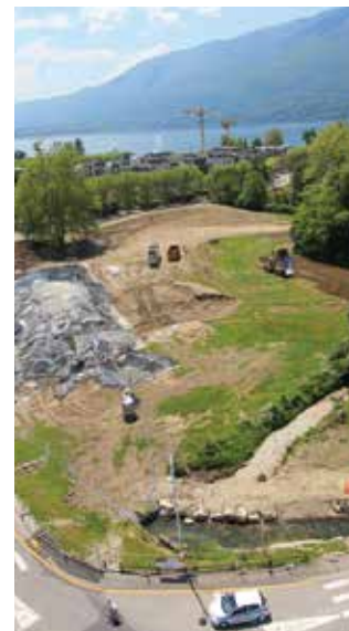
Le parc de la Bognette en chantier. Au 1 er plan, la dérivation provisoire du Tillet et l'ancien lit, à sec. À gauche, les matériaux en attente de criblage
