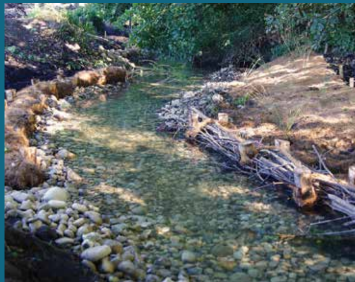
Le nouveau lit du Tillet avec ses graviers et ses fascines végétales qui vont rapidement verdifier les berges
