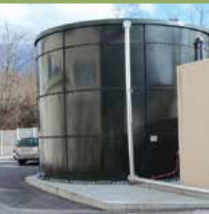
Cuve de prétraitement des eaux usées avant rejet dans le réseau
