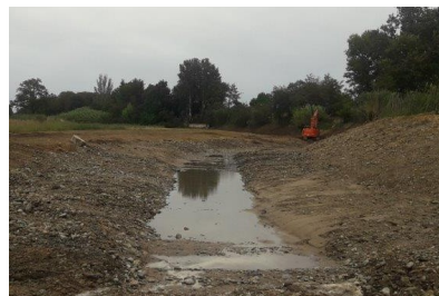
Travaux de terrassement - Tassio
