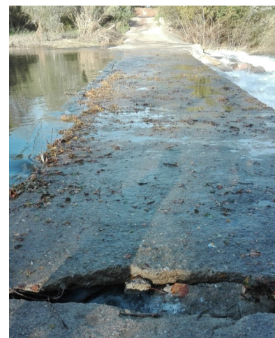
Passage à gué dégradé sur le Tech à Ortaffa
