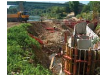
Chantier sur le seuil de Vallon-Salavas (juin 2009)
