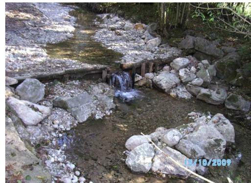
**Travaux prévus au CR :** Créer une fosse d'appel et une faille dans le seuil (hauteur 40 cm) pour créer une lame d'eau et l'abaissement de ce seuil (schéma ci-contre).
