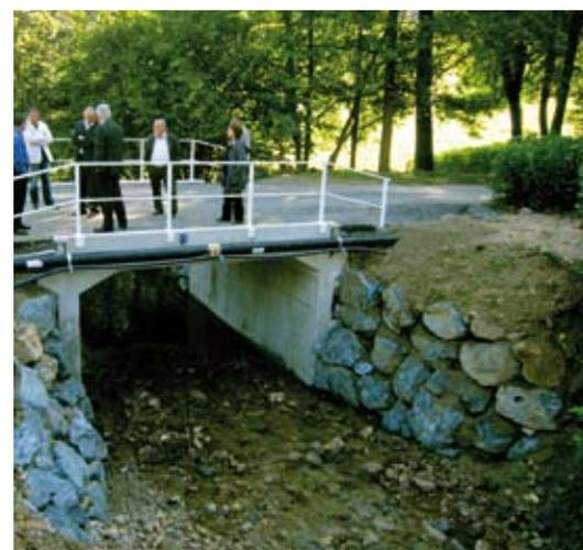
Depuis le 2 octobre, la circulation sur le pont des Gardonnes entre Thurins et Rontalon est rétablie. La stabilité de l'ancien ouvrage d'art étant menacée par l'érosion des berges, il a été décidé de reconstruire l'ouvrage et de le dimensionner pour une crue d'occurrence centennale. Par ailleurs, ces travaux ont permis d'effacer un seuil d'1,50 mètre et de décloisonner la rivière Artilla sur 3 km. Cette suppression permet désormais aux poissons d'accéder aux zones de frai situées en amont.
