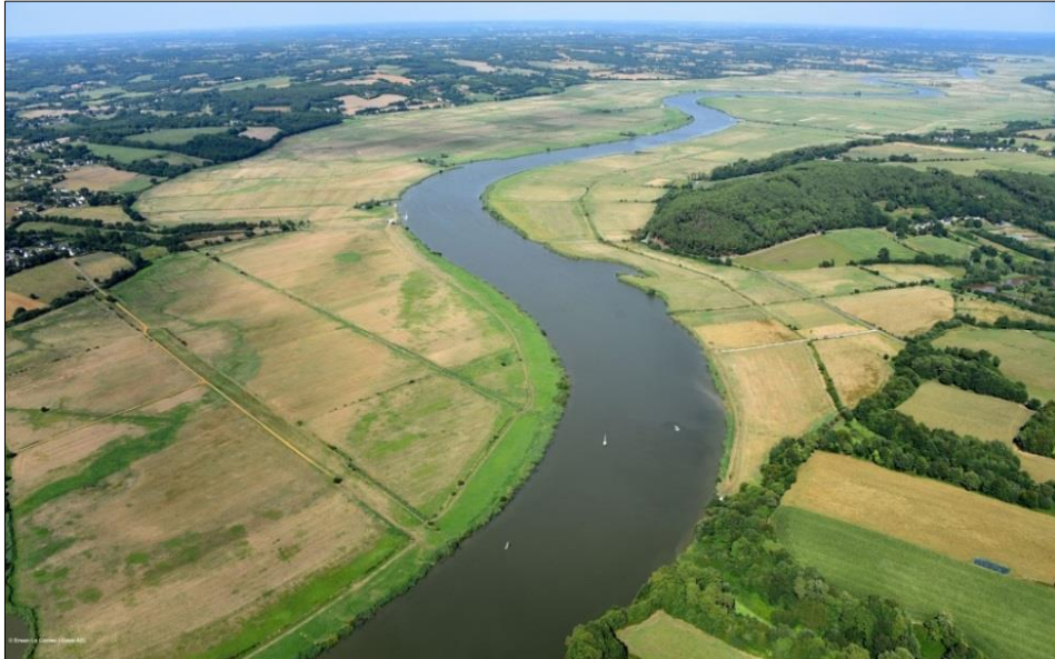
La Vilaine maritime au niveau des marais de Redon
