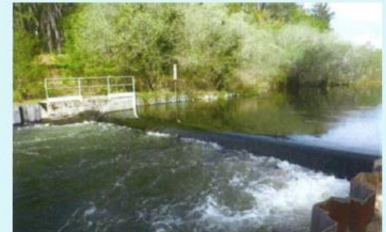
Barrage de Taffarde en régime noyé le 04/05/2012 (Source: ECOGEA)
