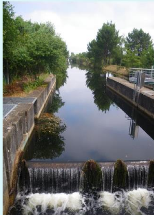
Barrage de Navarrosse
