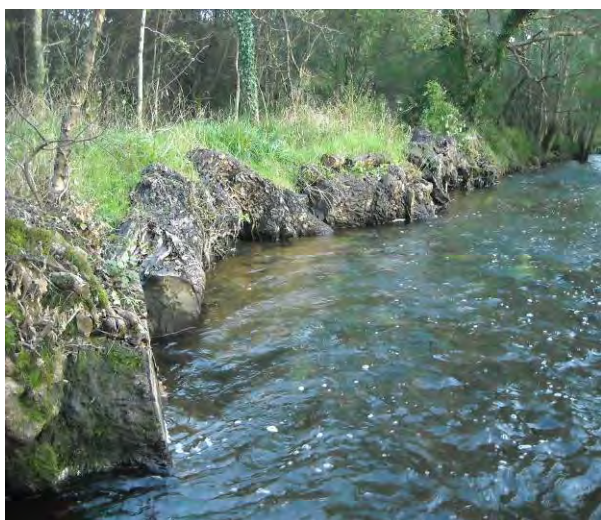
Exemple : Protection de rive et fascine à Keramperhec sur la commune de Kernével
