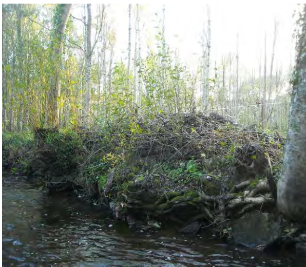
Exemple : Protection de rive et fascine à Keramperhec sur la commune de Kernével
