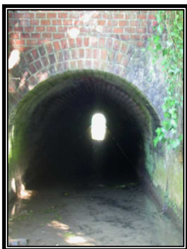
Figure 12 : Aqueduc permettant le passage des eaux de l'Agache sous le Canal du Nord à Inchy-en-Artois.
