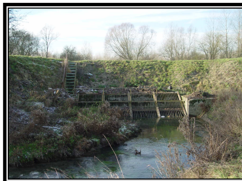
Figure 11 : Passage en siphon de l'Agache sous le Canal du Nord à Oisy-le-Verger.
