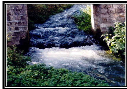
Figure 7 : Seuil artificiel sur l'Agache à Marquion.
