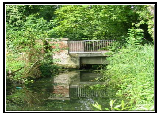
Figure 8 : Pont sur la Sensée à Aubigny-au-Bac (D247).
