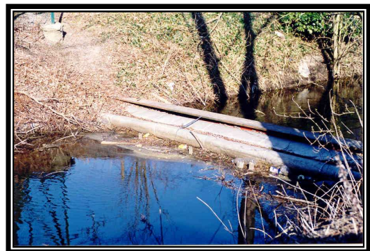
Figure 4 : Conduite d'assainissement à Féchain.
