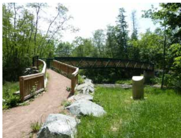
Passerelle du Grand Pré sur le Lignon (Pays d'Astrée)
