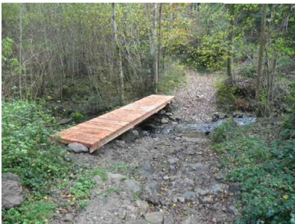
Passerelle sur le Bouchat (Loire Forez)
