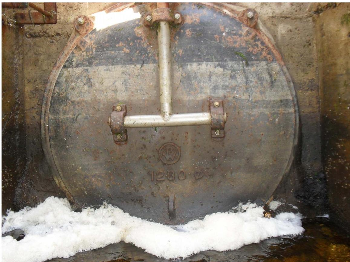
Clapet à marée ou clapet à flot, maintien un écoulement par le ruisseau, en limitant les entrées d'eaux marines.
