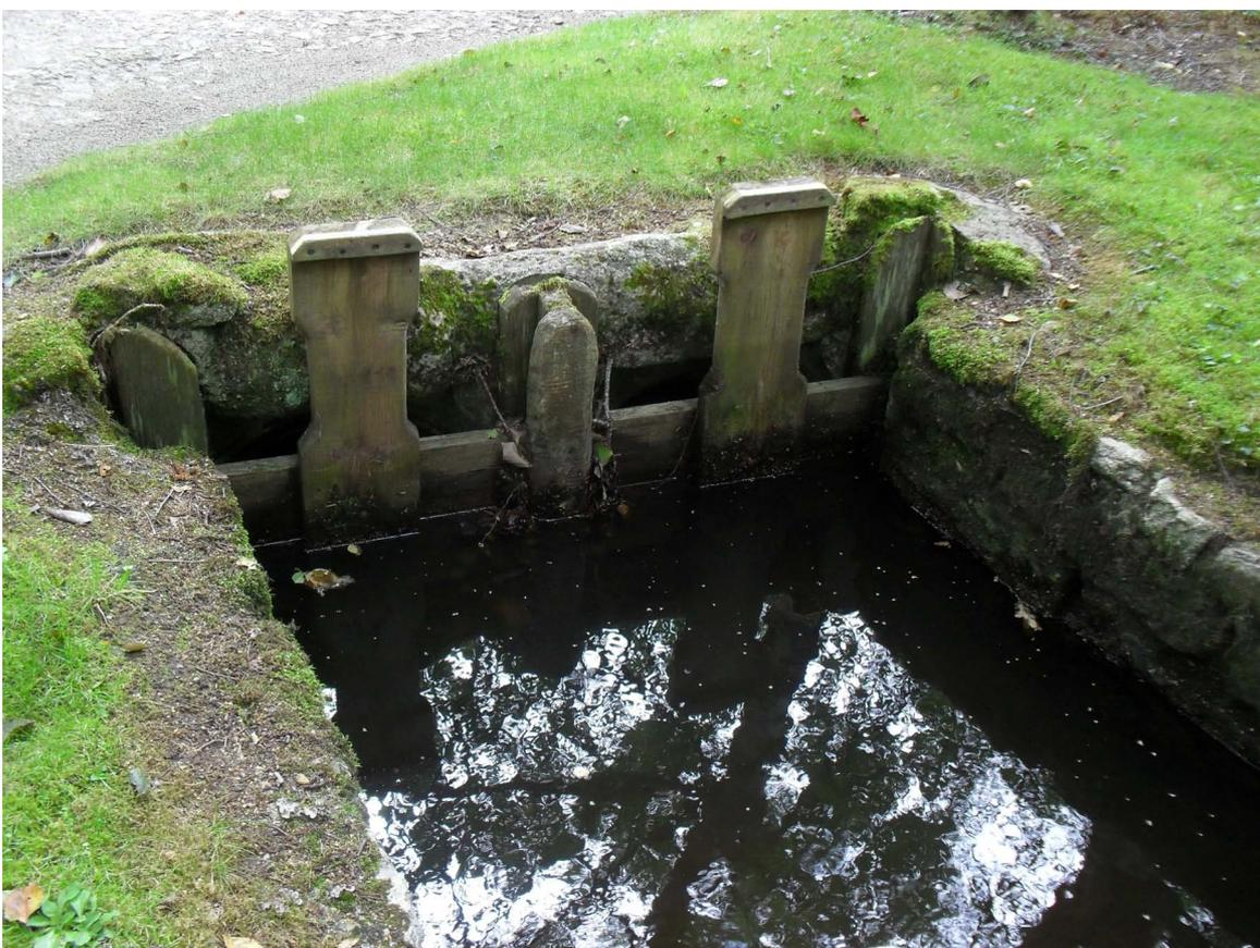
Les prises d'eau des rampes se fait à travers ce panneau levant doublé d'une grille fine.
