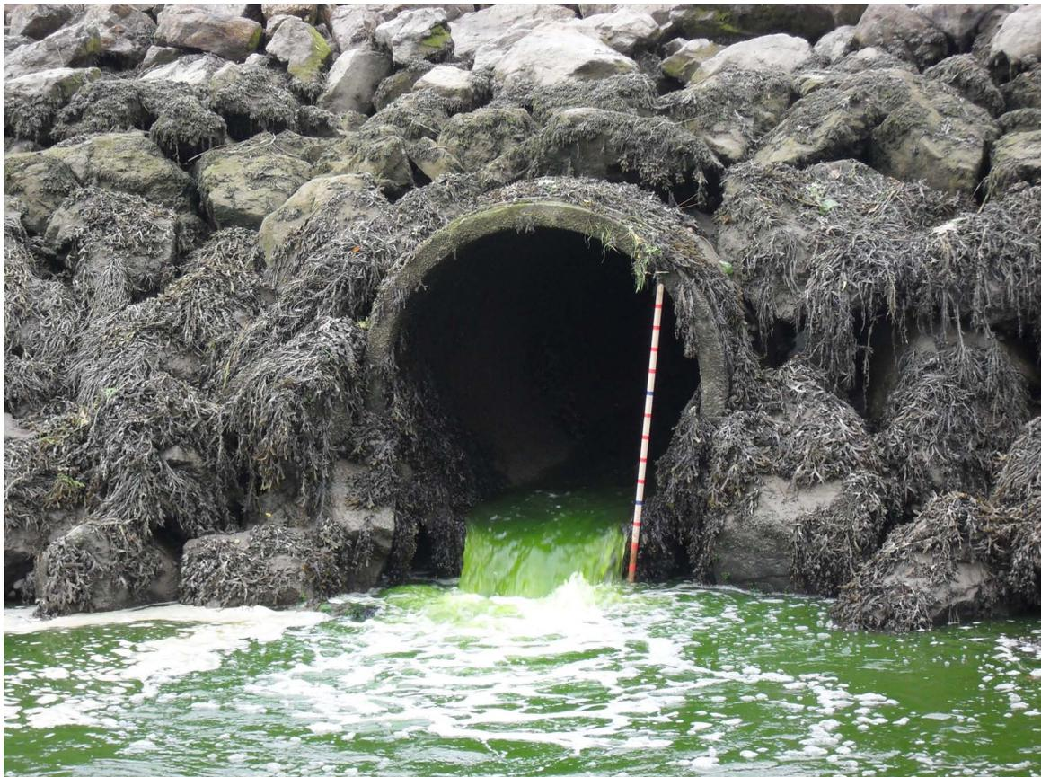
Sortie de buse à marée basse, même si la hauteur de chute est franchissable pour les salmonidés, le courant est trop fort sur une longueur trop importante pour permettre le franchissement.
