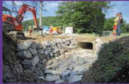
Mai, des travaux pour stopper l'érosion provoquée par les crues du Broulon à Montagny. 7 609 € HT
