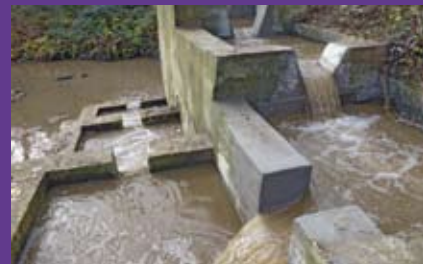
Décembre, remise en eau après rénovation de la passe à poissons sur le Fondagny à Mornant. 3 900 € HT.
