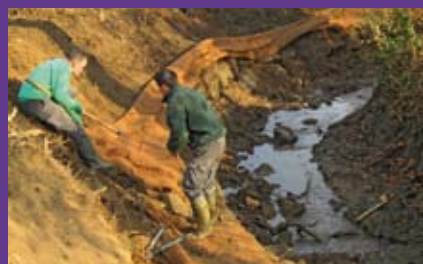
Octobre à décembre, travaux sur le secteur du pont du Charvon sur le Fondagny à Saint-Maurice-sur-Dargoire. Ici, pose d'un géotextile en coco pour renforcer les berges. 36 000 € HT
