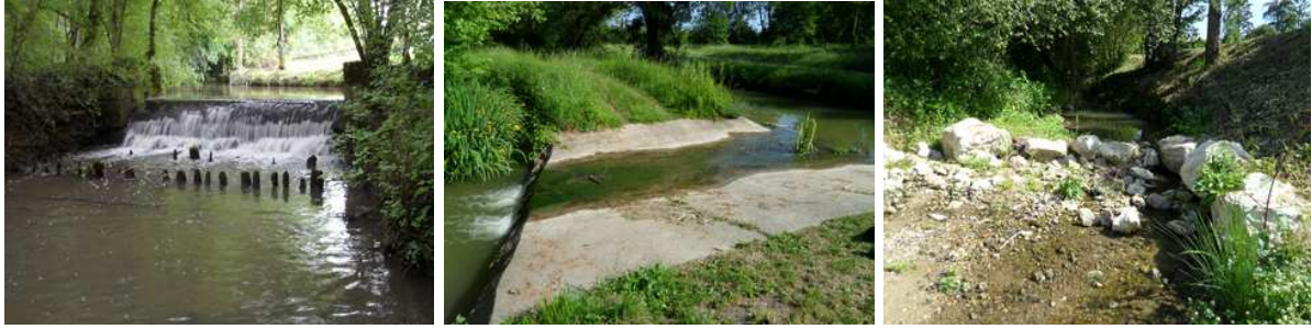
Figure 2 : Exemples d'éléments fixes ; un déversoir, un radier et un enrochement sur le bassin
