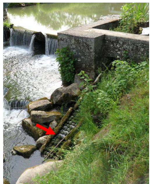
Figure 4 : Clapet basculant aménagé avec une passe à anguilles type plot sur le Fouzon
