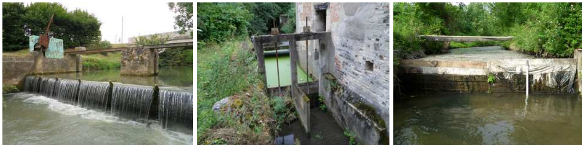
Figure 3 : Exemples d'éléments mobiles ; un clapet, une vanne levante et un batardeau sur le bassin
