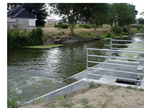
Photo 3 : Pompage en Loire (station de Saint-Martin-la-Place)
