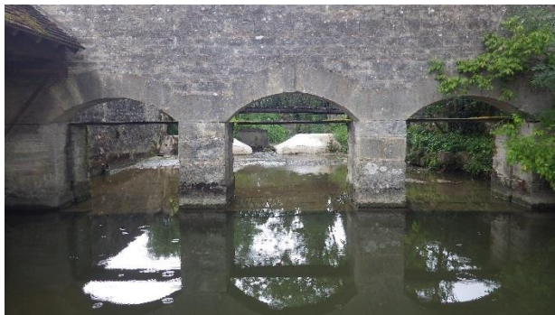
NOR.06 – Goulotte site AFPA – Seuil arasé sur le site AFPA
