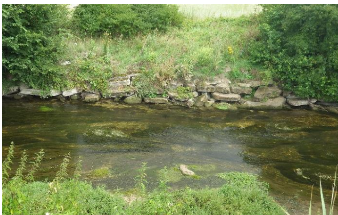
Figure 11 : Type de berges T4 non érodable en raison de l'artificialisation des berges – la Norges entre Magny sur Tille et Genlis
