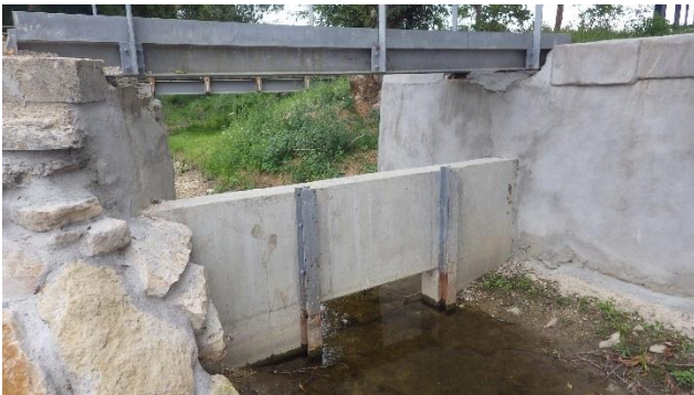
NOR.06 — Difffluence Norges/Goulotte - ouvrage répartiteur
