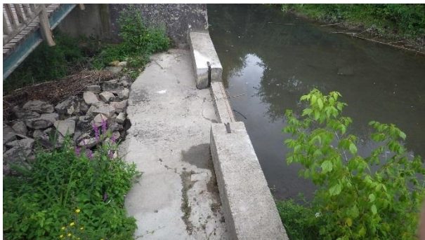
NOR.06 – Difffluence Goulotte/Rivière Neuve, déversoir latéral
