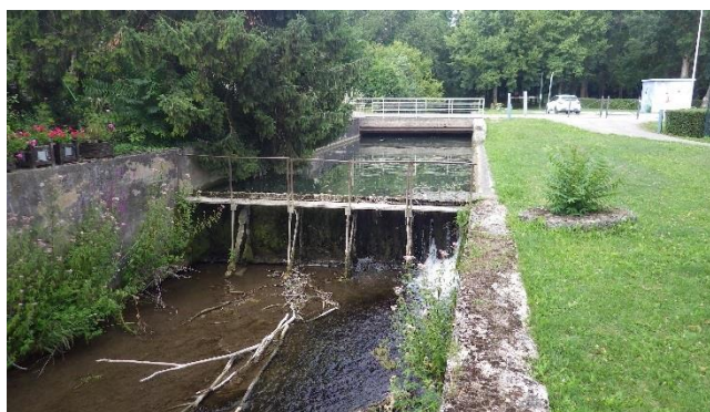
NOR.05 - Norges à Couternon – Barrage à aiguilles de Couternon
