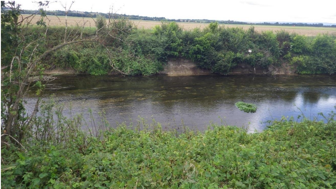
A2) Tronçon NOR.08 très rectiligne présentant une érosion caractérisée de linéaire
