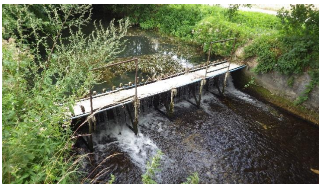
NOR.03 - Norges en aval du lieu-dit la Verne – Seuil pour pompage agricole
