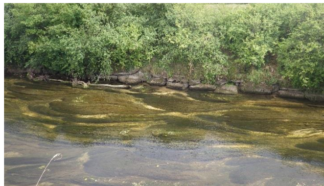
NOR.07 – Norges en aval de Magny sur Tille - Berges enrochées au droit des terres agricoles et algues filamenteuses
