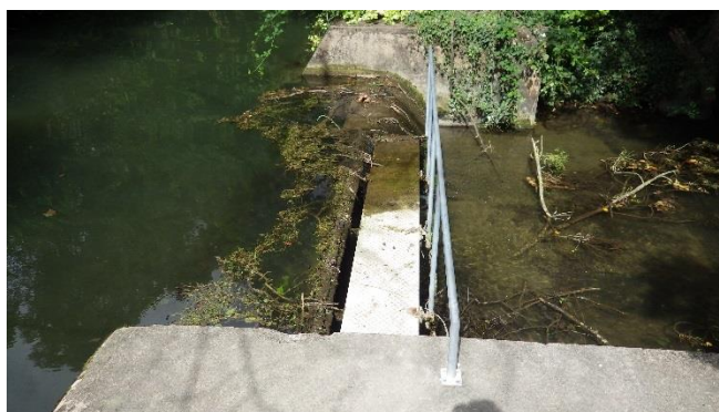
NOR.05 – Norges à Couternon – Seuil latéral en béton d'alimentation de la Vieiller Tille
