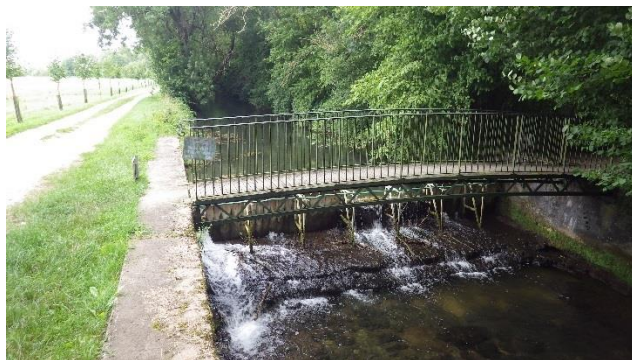
NOR.03 - Norges en amont de Orgeux – Barrage à aiguille de Orgeux
