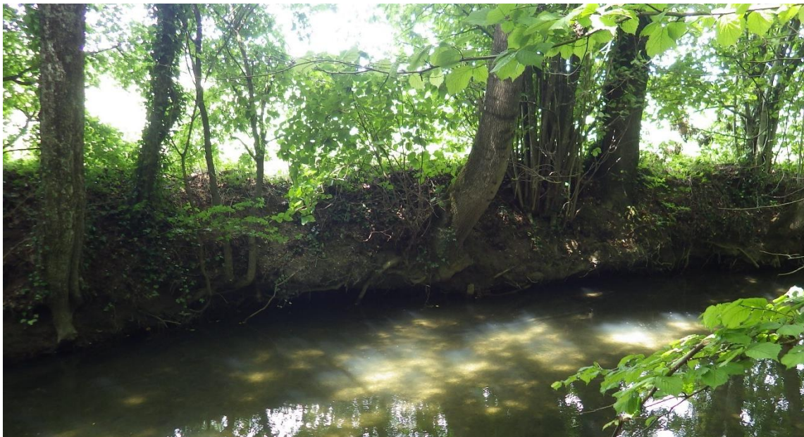
B1) Recul de berge sur le NOR.03 avec probable sous cavage du système racinaire
