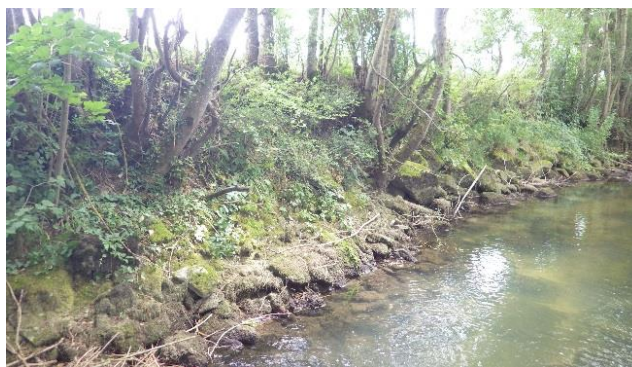
NOR.03 - Norges dans le secteur recalibré– Protections de berges en enrochements
