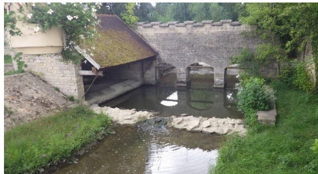
NOR.06 – Goulotte site AFPA – Seuil en enrochements bétonnés en aval du site AFPA
