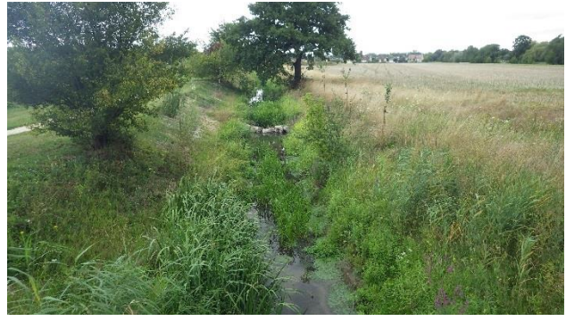
NOR.06 – Restauration physique de la Rivière Neuve en amont de l'ancienne voie ferrée
