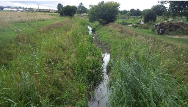
NOR.06 – Restauration physique de la Goulotte aval au droit des jardins ouvriers
