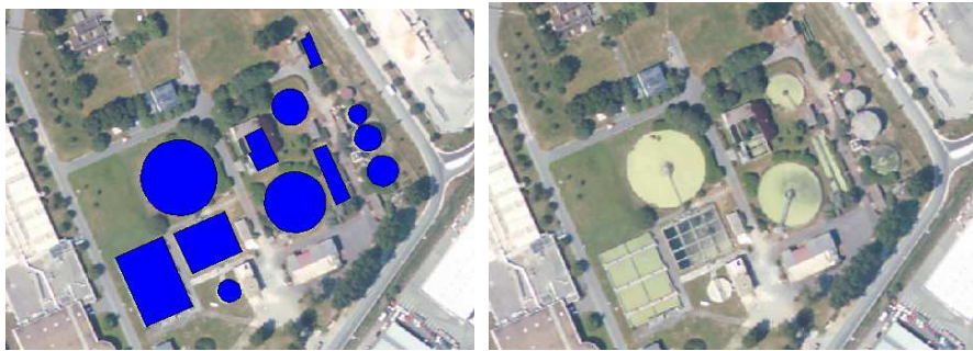
Les bassins de stations d'épuration sont incorporés dans la BD TOPO en tant que « bassin ».
