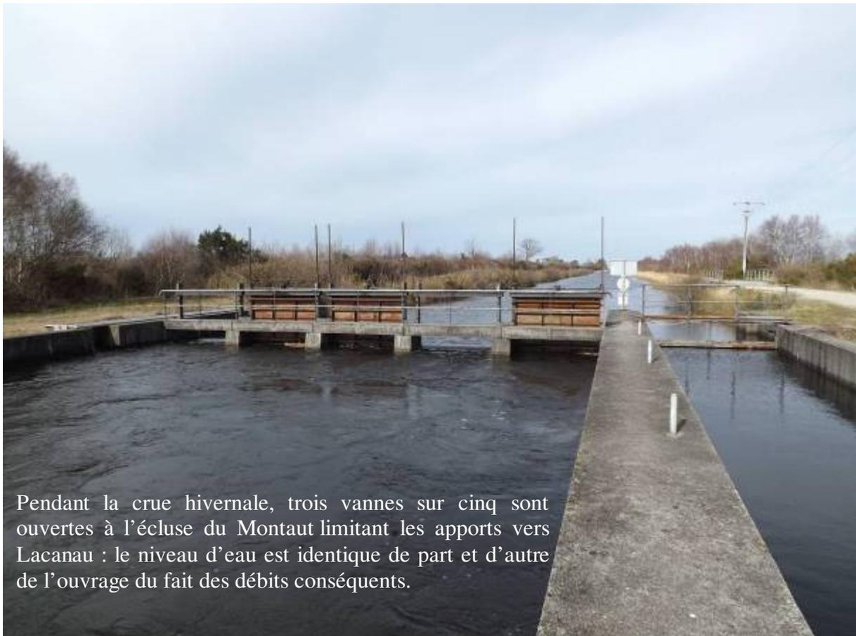
Pendant la crue hivernale, trois vannes sur cinq sont ouvertes à l'écluse du Montaut limitant les apports vers Lacanau : le niveau d'eau est identique de part et d'autre de l'ouvrage du fait des débits conséquents.
